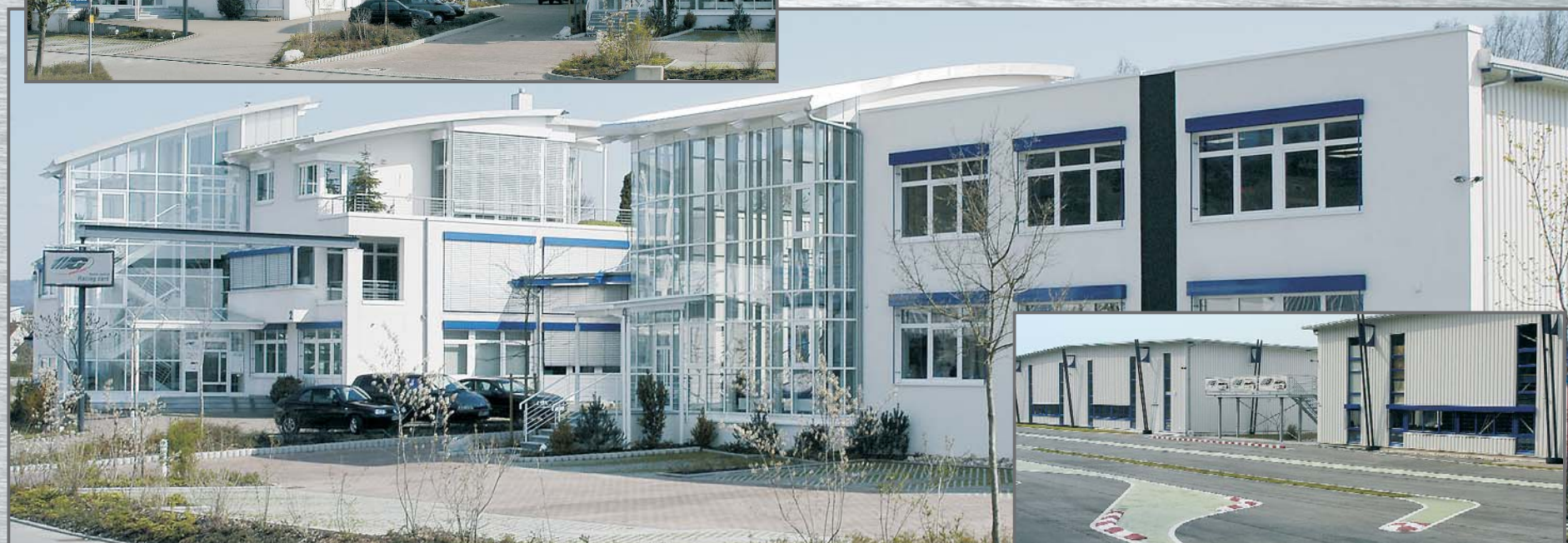
Teststrecke mit ca. 320m Länge testtrack with a length of approx. 320m
